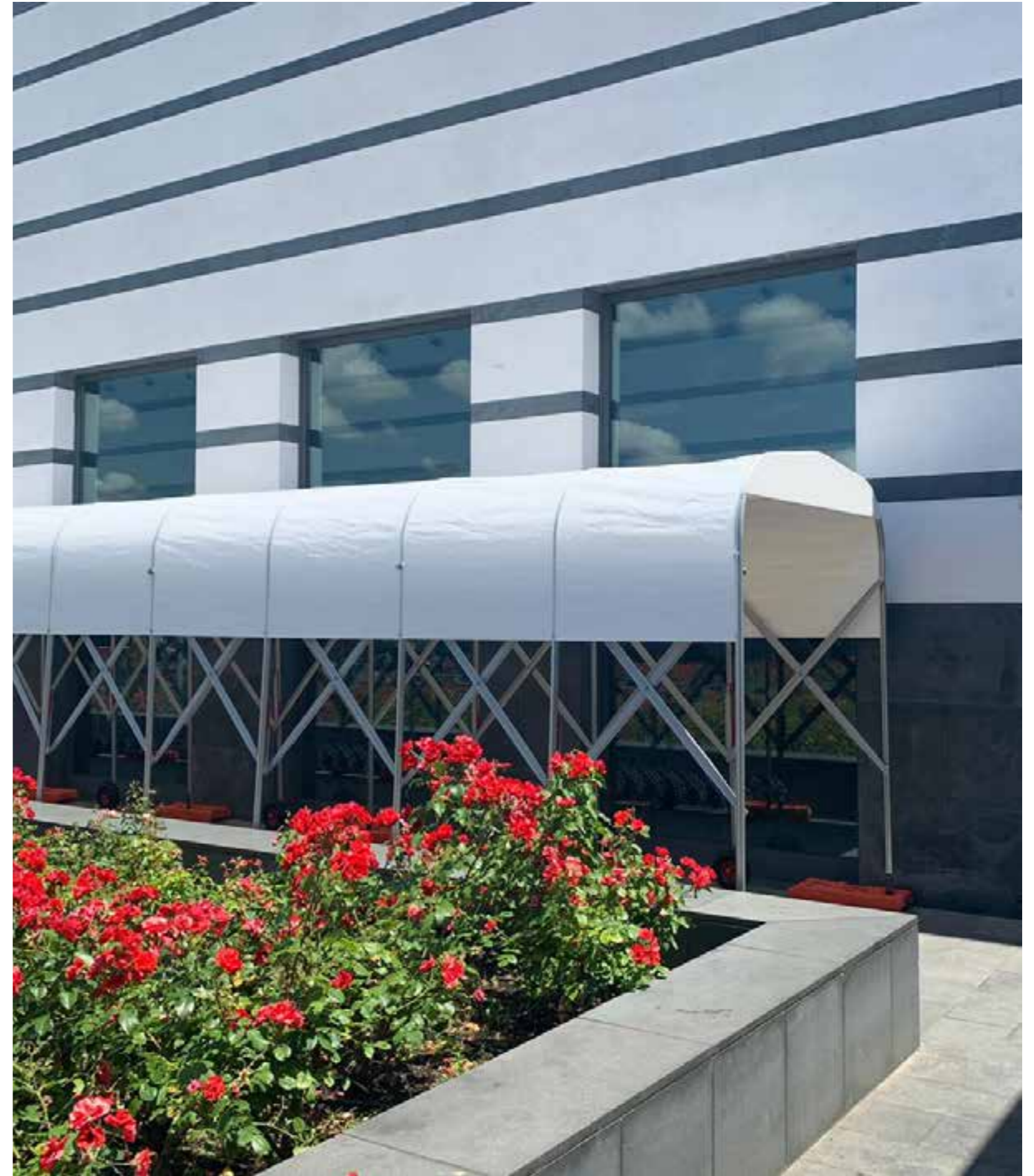
USO Passerella coperta
